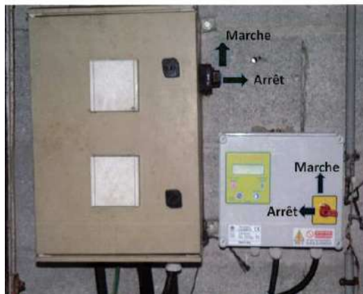
Mise sous tension et Démarrage de la Pompe Hydraulique
