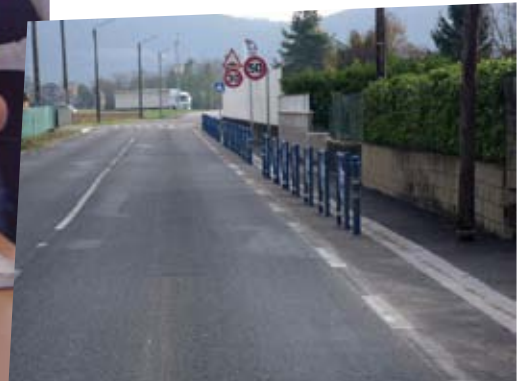
Sécurisation de la rue Grange Peyraud
